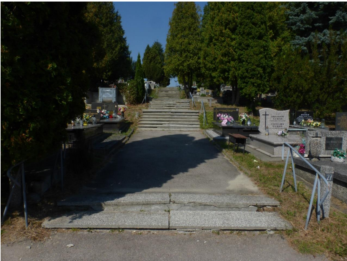
WIDOK NA TRZY CIĄGI SCHODÓW DO REMONTU
