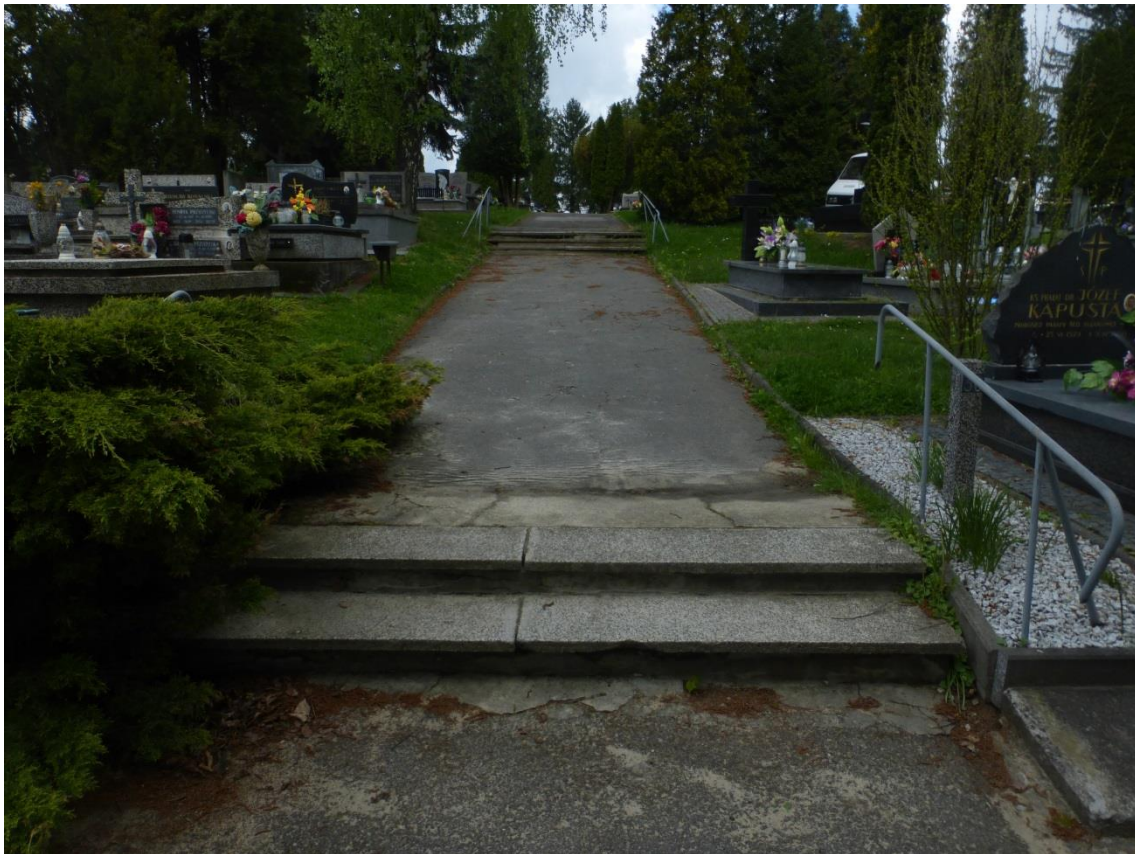
WIDOK NA DWA CIĄGI SCHODÓW DO REMONTU
