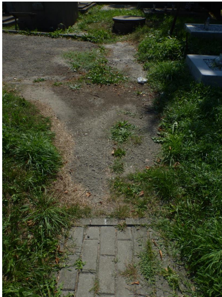
WIDOK NA FRAGMENT ALEJKI DO REMONTU MIĘDZY KWATERAMI VI A XXIII
