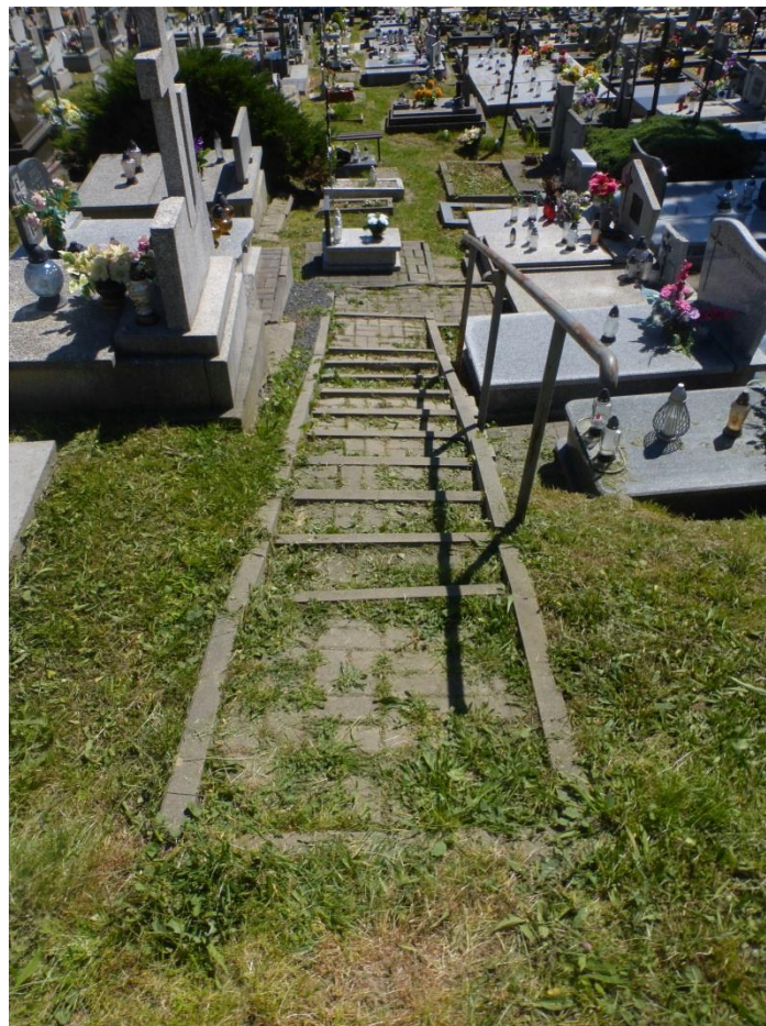
WIDOK NA CIĄG SCHODÓW
