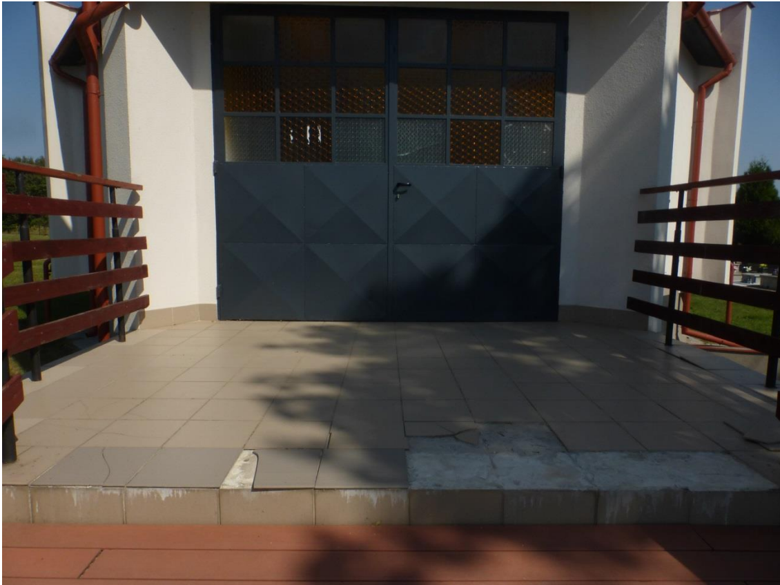
WIDOK NA SCHODY DO REMONTU
