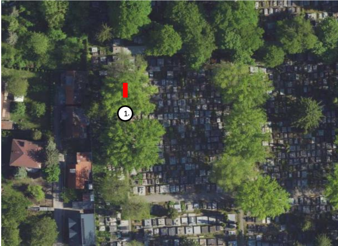
1 – Fragment alejki z kostki betonowej (2,9 m x 0,85 m)
